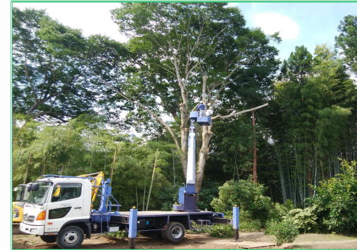
高所作業車による伐採
